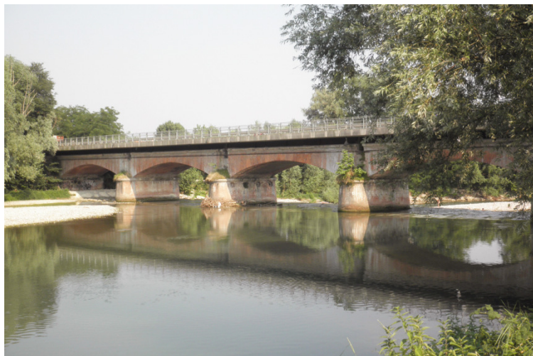
Foto 2 – Sezione del Fiume Oglio in corrispondenza del ponte che collega Soncino (CR) con Orzinuovi (BS)
