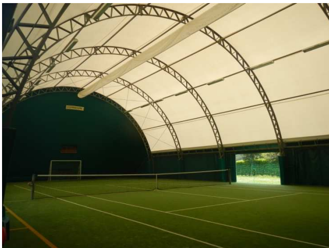
Foto 7 – Area ammassamento soccorsi – Tendone A - Campo coperto polivalente
