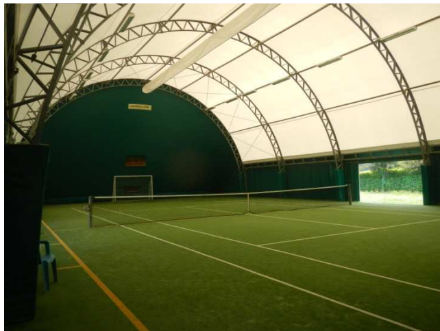
Foto 6 – Area ammassamento soccorsi – Tendone A – Campo coperto polivalente
